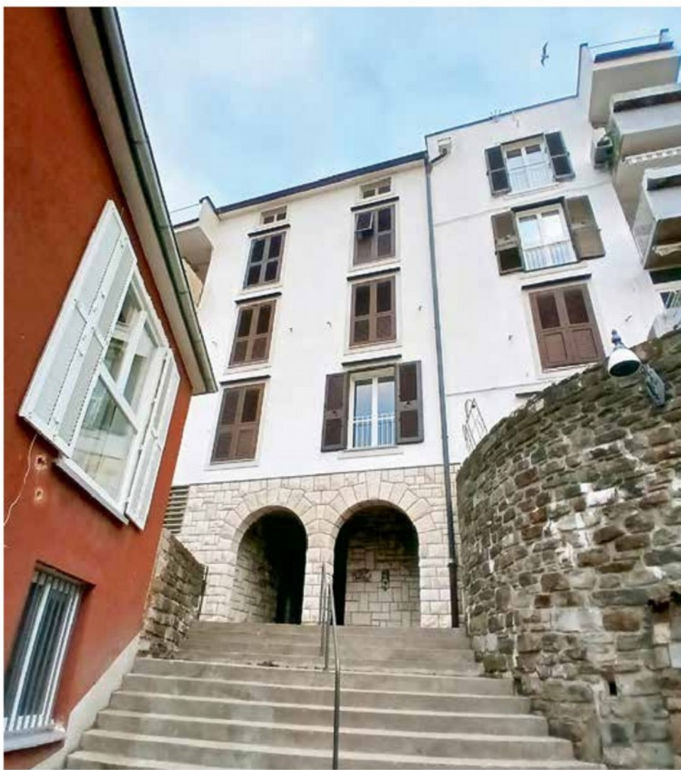
Podhod pod blokom, ki povezuje Nazorjev trg in Resslerovo ulico, dnevno uporabljajo stanovalci in drugi občani, pa tudi turisti. Pogled z Resslerove ulice.
