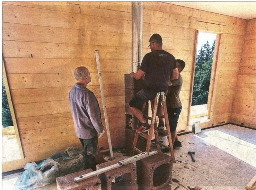
Ob vgradnji sodobne kurilne naprave je potrebna tudi gradnja sodobnega dimnika.
